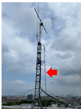
図 19 台風で壊れたアンテナ
